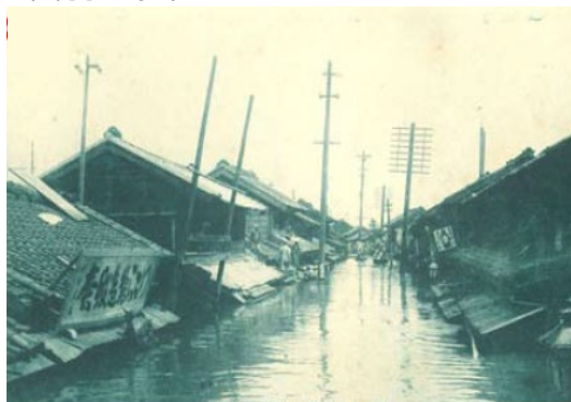
明治43年 東京大水害（千住付近）
