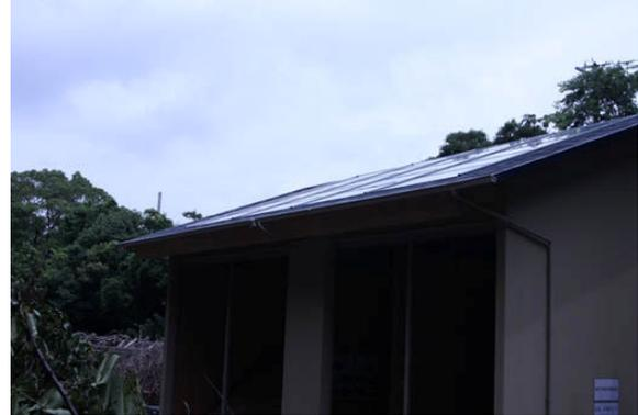
写真 4.2 ソーラー式チップ乾燥貯蔵保管庫
