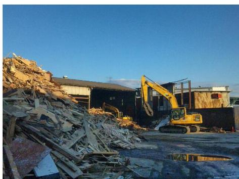
写真 2.12 重機による解体材の一次破砕
